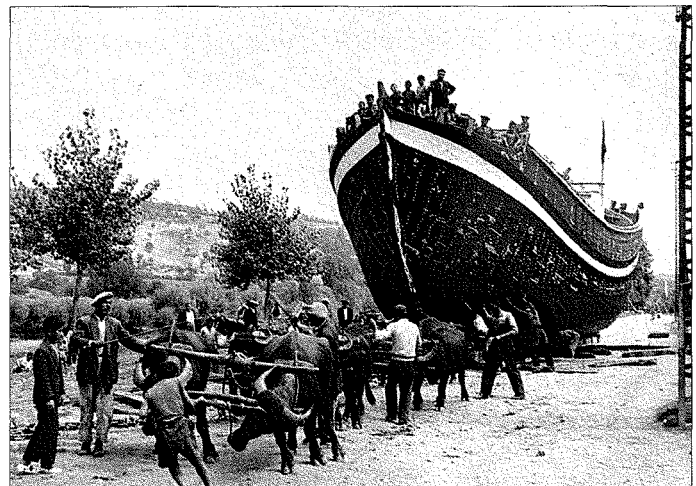
Bartın'da XX. yüzyıl başlarında inşa edilen bir teknenin mandalarla çekilerek denize indirilişini gösteren bir fotoğraf
